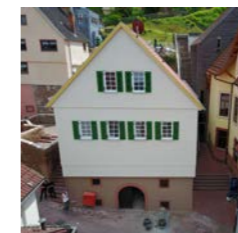
62 Sanierung Wohnh., Freudenberg
