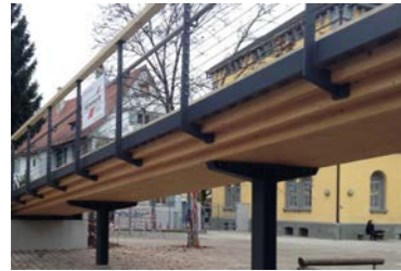
33 Blockträgerbrücke Braithschule, Biberach Riß
