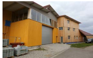
39 Produktionshalle mit Sozialtrakt, Merdingen
