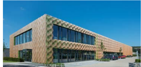
36 Logistikzentrum Elobau, Leutkirch
