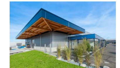
60 Produktionshalle mit Büro, Schwäbisch Hall
