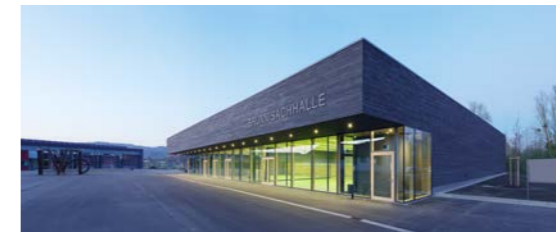
59 Mehrzweckhalle Kluftern, Friedrichshafen
