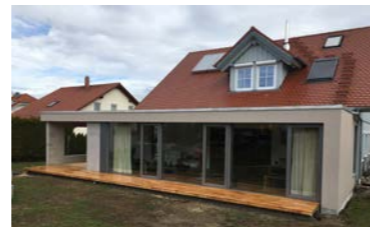
14 Erweiterung Wohnhaus, Hechingen-Weilheim
