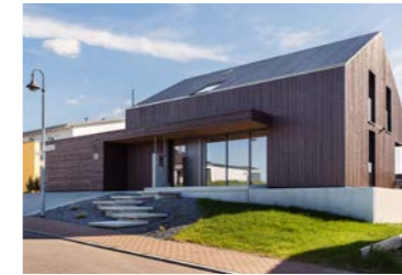
53 Wohnhaus M, Villingendorf
